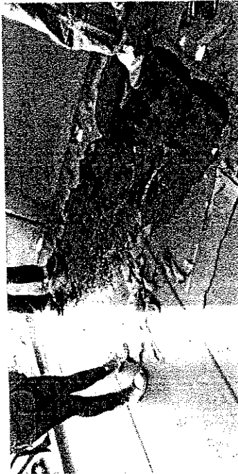
BL12EG Demolicion Manual de impermeabilizante.
